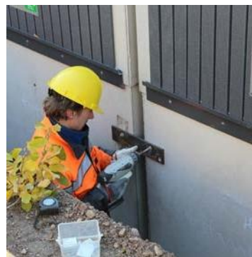
Joonis 6. Konteinerite ühendamine
