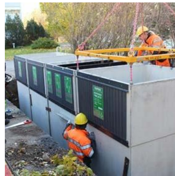
Joonis 5. Tasapinnalisuse kontrollimine
