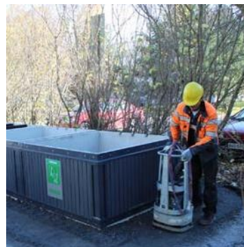
Joonis 7. Täitmine ja lõppviimistlus
